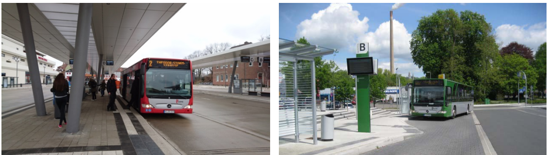
Abbildung 17: Moderne Verknüpfungsanlagen mit hohem Ausbaustandard hinsichtlich der Barrierefreiheit (links: Zentraler Omnibusbahnhof ZOB Hildesheim; rechts: Alfeld (Leine) Bahnhof)
