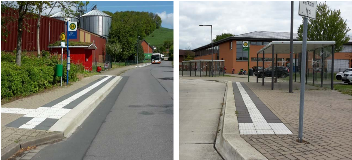
Abbildung 16: Nach aktuellem „Stand der Technik“ ausgebaute Haltestelle mit Ausbildung als Fahrbahnrandhaltestelle, niederflurgerechtem Sonderbord und taktilem Leitsystem aus Bodenindikatoren (Beispiel: links: Haltestelle Bad Salzdetfurth, Solebad; rechts: Gronau Schulzentrum)
