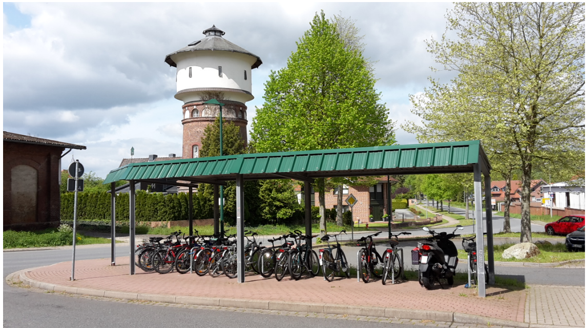
Beispiel: Bodenburg Bahnhof
