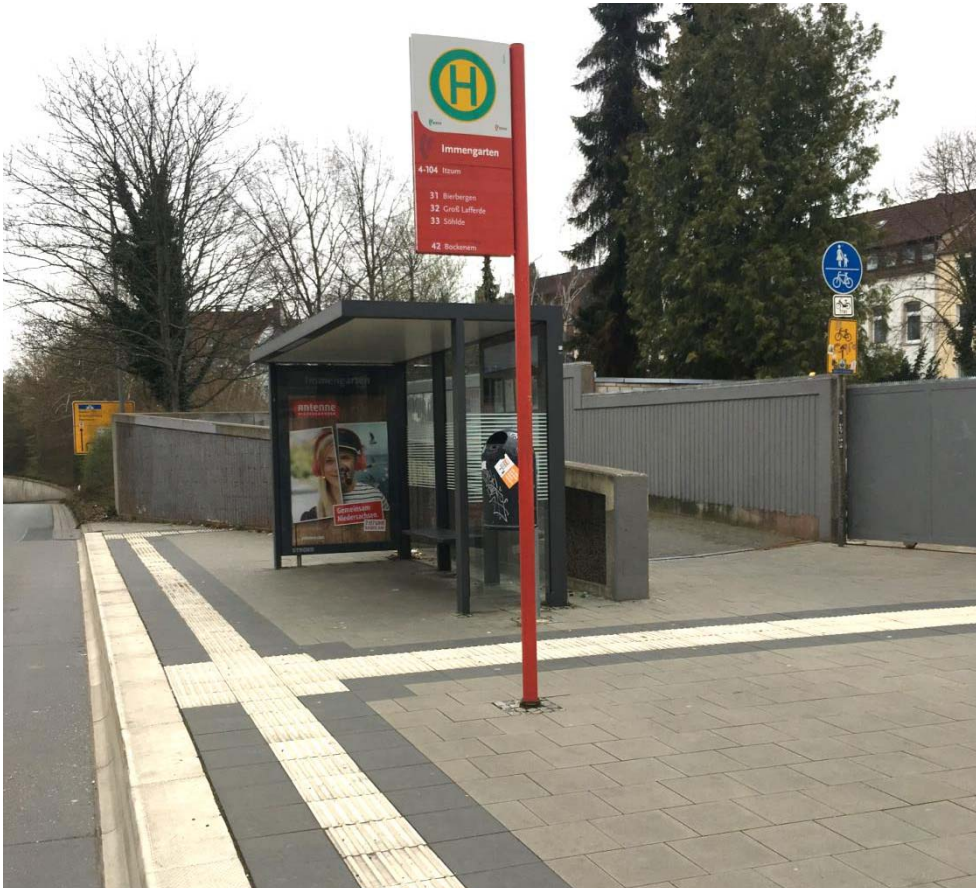
Abbildung 31: Nach aktuellem „Stand der Technik“ ausgebaut Haltestelle mit Ausbildung als Fahrbahnrandhaltestelle, niederflurgerechtem Sonderbord und taktilem Leitsystem aus Bodenindikatoren (Beispiel: Haltestelle Immengarten)
