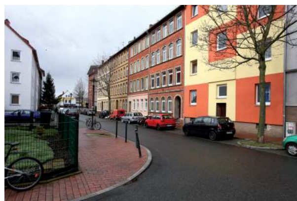
Sanierter Straßenraum und sanierte Gebäudefassaden in der Hermannstraße
