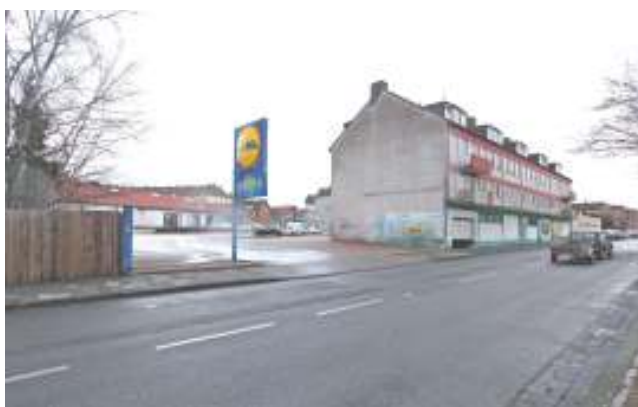
Städtebauliche Defizite an Gebäuden und im Straßenraum im Bischofskamp
