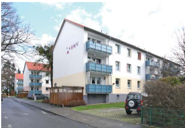
Sanierte Geschossbauten des BWV in der Richthofenstraße
