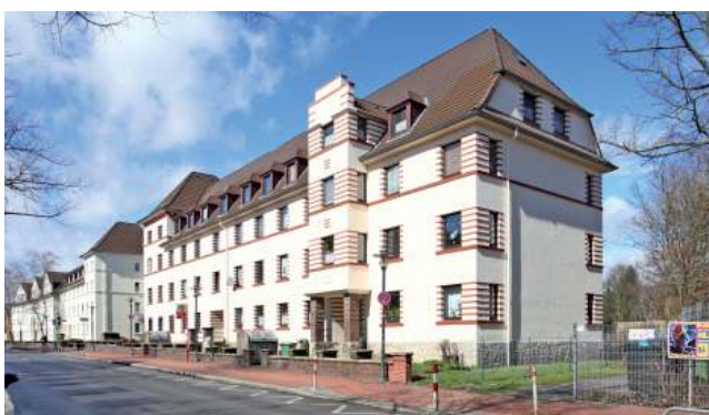
Blockrandbebauung aus unterschiedlichen Entstehungszeiten (Martin-Luther-Straße)
