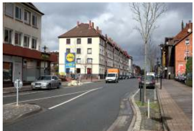
Sanierter Straßenraum in der Steuerwalder Straße
