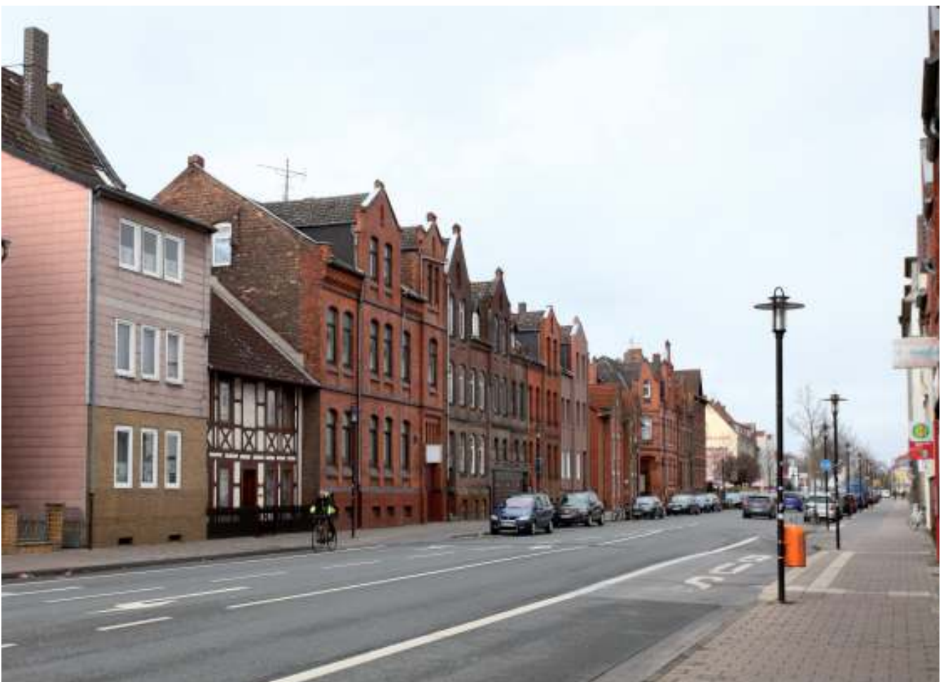
Typische Blockrandbebauung in der Steuerwalder Straße
