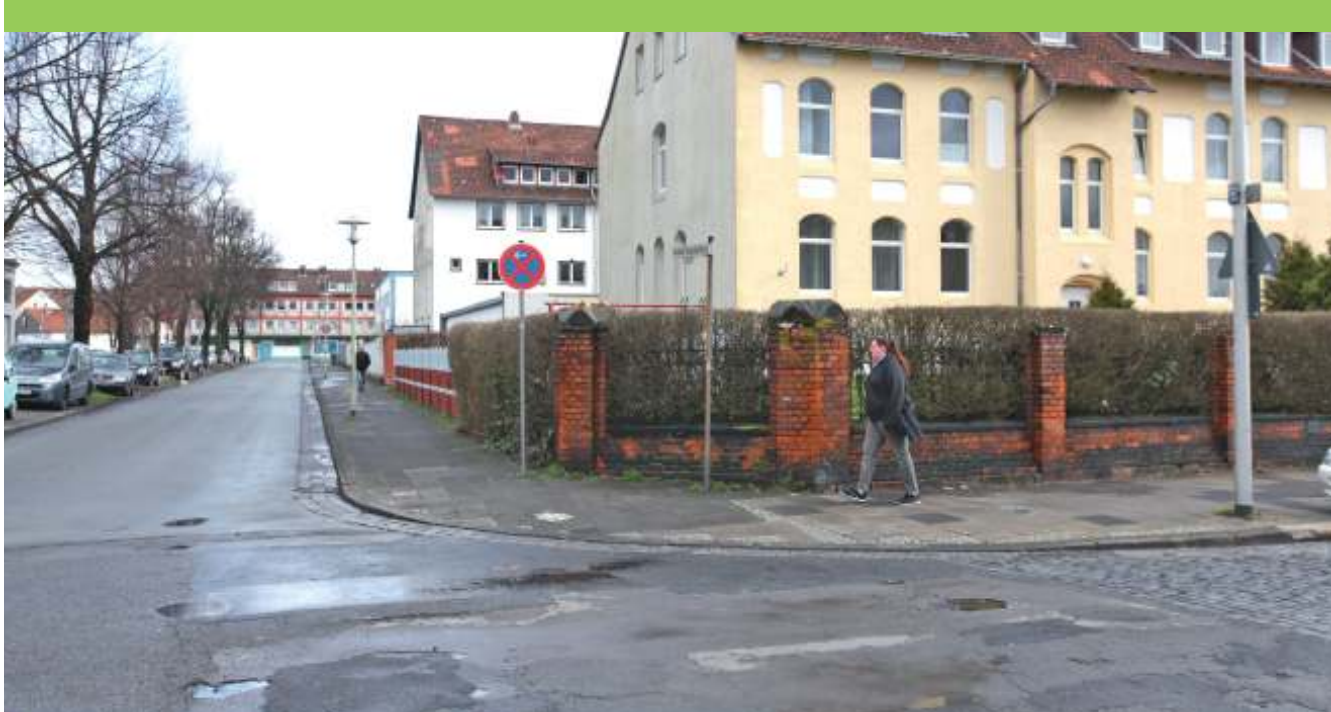
Sanierungsbedarf in der Senkingstraße, Ecke Bischofskamp
