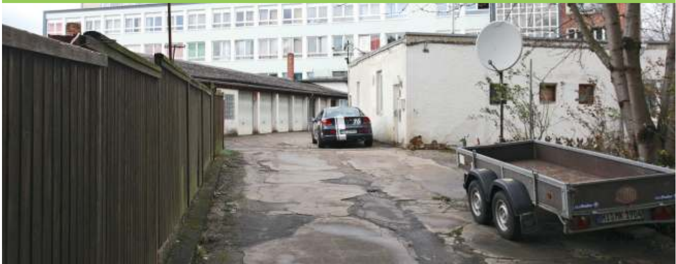
Entsiegelungs- und Sanierungsmaßnahmen für versiegelte Flächen in den Hinterhöfen (hier: Steuerwalder Straße)
