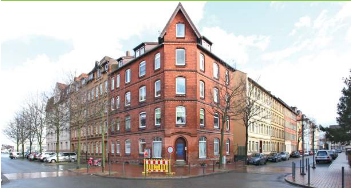
Typische Blockrandbebauung der Gründerzeit in der Hermannstraße, Ecke Bischofskamp
