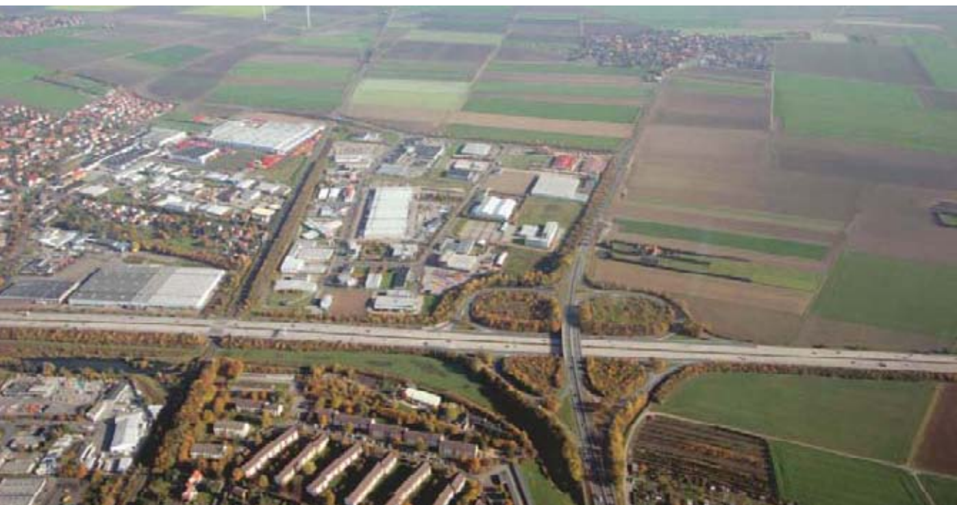
Autobahnanschlussstelle Hildesheim Richtung Einum
