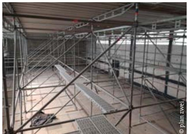
Die Halle ist entkernt. Dämmung und Fenster werden eingebaut.
