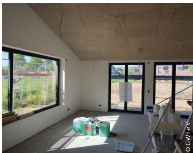
Der Innenausbau des Quartierszentrums ist in vollem Gange.
