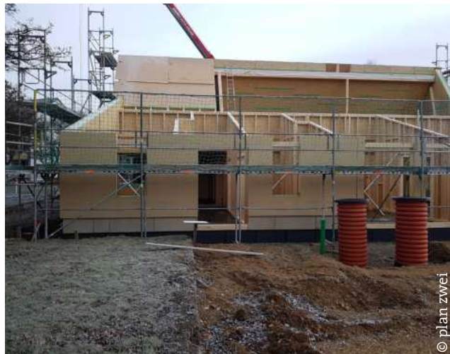
Januar 2023: Hochbau in Holzständerbauweise
