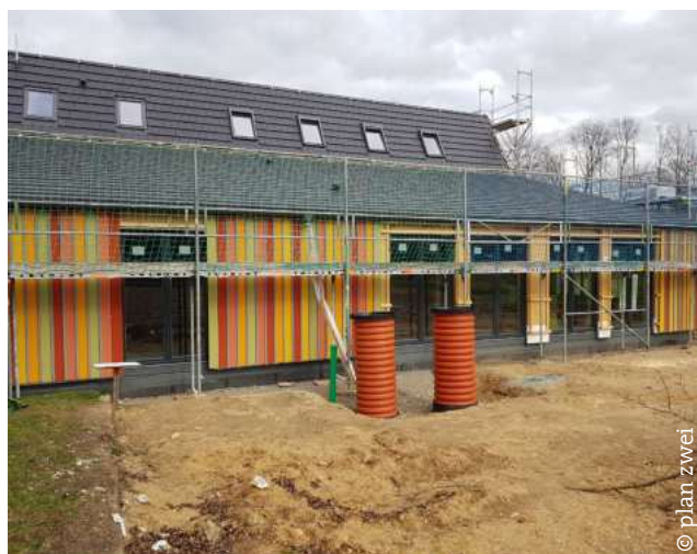
März 2023: Holzverkleidung, Dacheindeckung und Fenster
