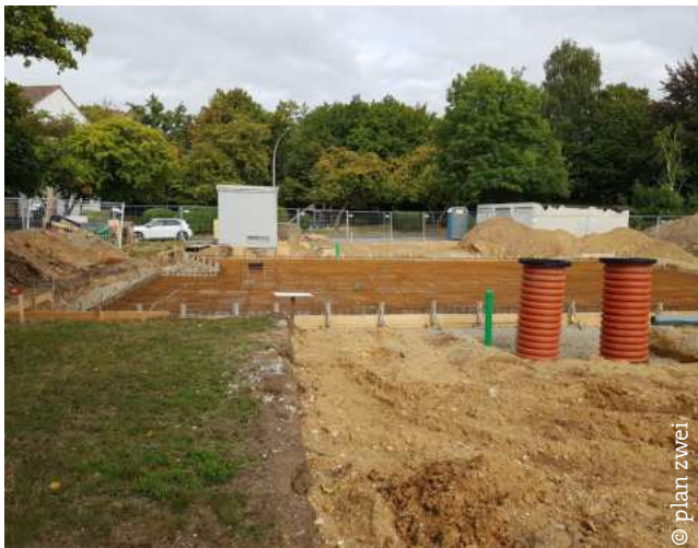
September 2022: Herstellung der Bodenplatte
