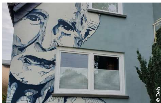
Die Sanierung schreitet an der nächsten Hauswand voran.
