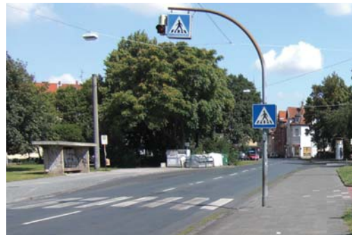
Abb. 52: Querungshilfe im Bereich Steingrube (Moltkestraße / Roonstraße)
