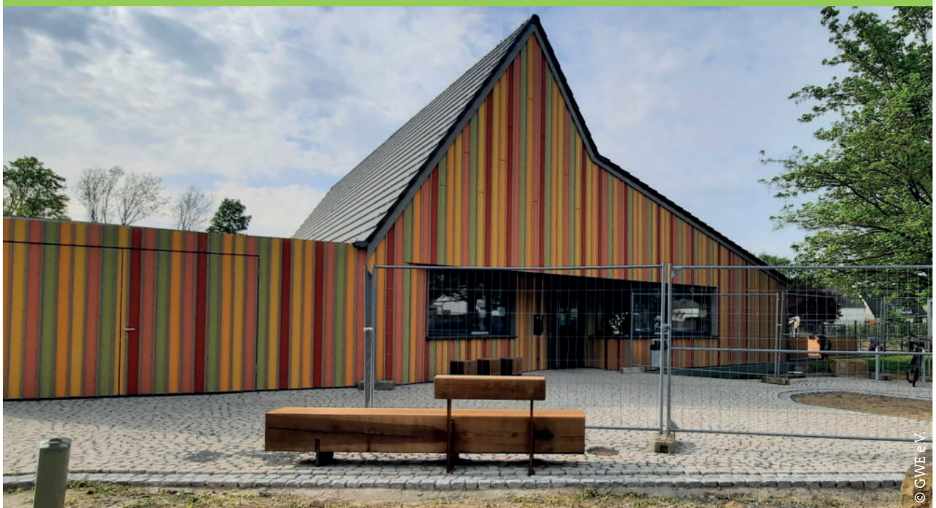
Noch steht der Bauzaun, der Vorplatz ist aber fast fertig.
