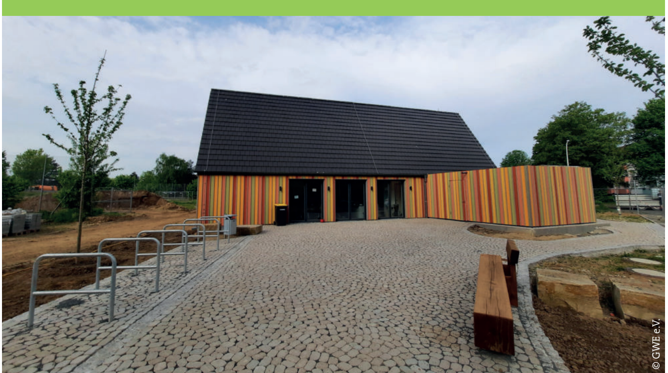
Der Vorplatz zieht sich um das Quartierszentrum herum und bildet einen weiteren großzügigen, aber geschützteren Raum.
