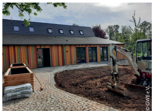
Auch im Garten schreiten die Arbeiten voran.
