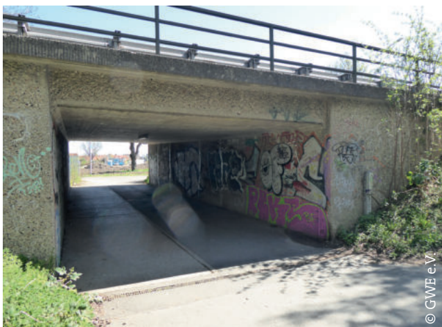
Die südliche Unterführung
