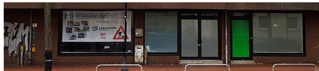
Im Erdgeschoss der Martin-Luther-Straße 41a soll ein Kultur- und Bildungszentrum entstehen. Das tpz und die Lebenshilfe werden hier einziehen.
