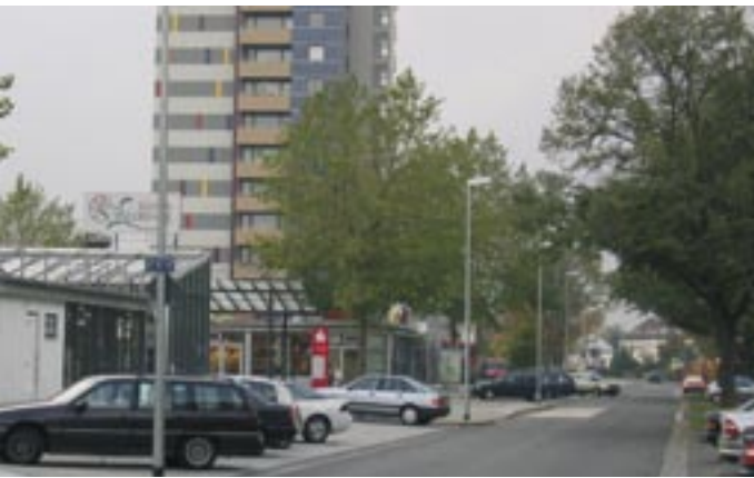
Neu: Schmale Fahrbahn, die leichter zu überqueren ist mit attraktiven Parkmöglichkeiten (Senkrechtaufstellung)
