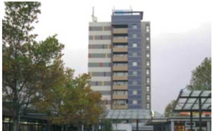
Das Hochhaus Ehrlicherstraße 18 mit neuer Fassade
