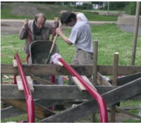
Qualifizierung: Bau des Trimm-Dich-Pfads (2008)
