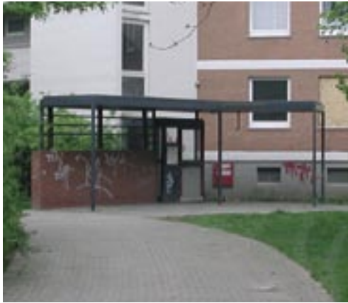
Vorher: Der alte Eingang zu Lohdestraße 2
