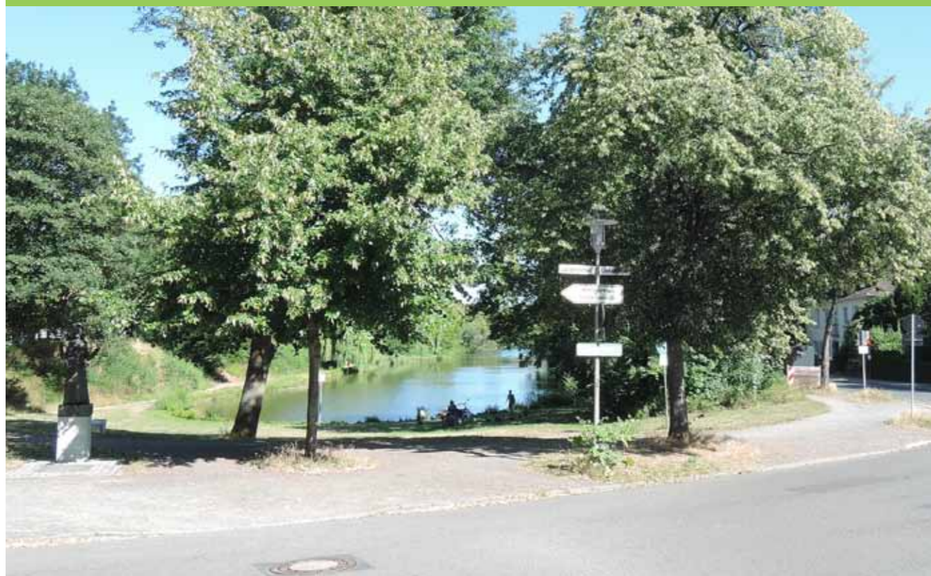
Abb. 140: Übergang zum Langelinienwall überdimensioniert
