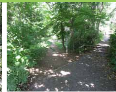
Abb. 108: Schlechter Zustand Hangwege
