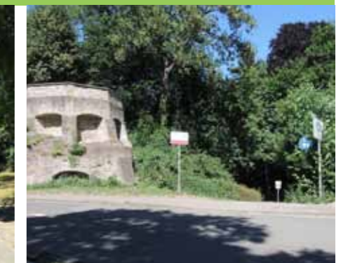
Abb. 186: Entree am Kehr wieder grund mangelhaft auffindbar
