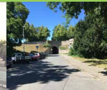
Abb. 184: Verbindung Dyesgraben – Kehr wieder grund mangelhaft auffindbar
