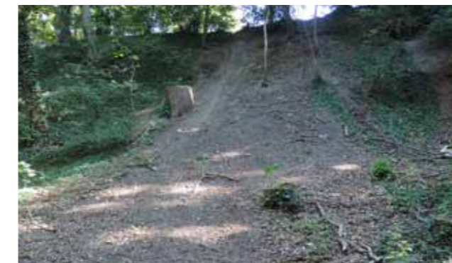
Abb. 038: Erosionsschäden infolge der fehlenden Hangvegetation
