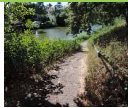
Abb. 151: Rampe zum Uferweg sanierungsbedürftig
