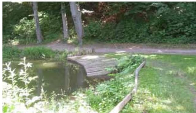
Abb. 122: Wasserzugang am Südende sanierungsbedürftig
