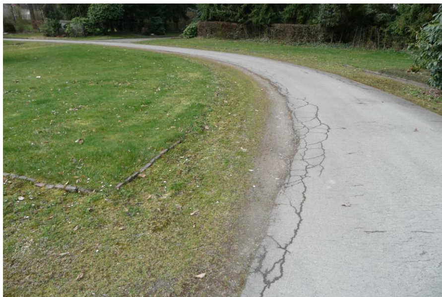
Abb. 16: Am westlichen Rondell sind die Kantensteine der Wegeeinfassung zu entfernen, es wird eine durchgehende Rasenfläche bis zum Bitumen-Belag geschaffen, ohne „Restflächen“ (Foto: Bertram)
