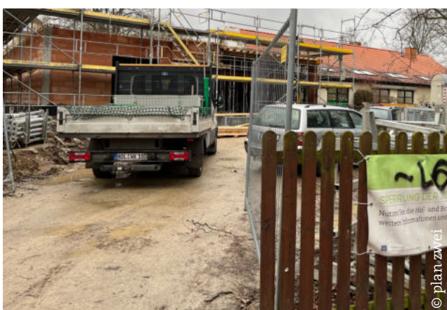
Mittlerweile ist das neue Gebäude gut zu erkennen.
