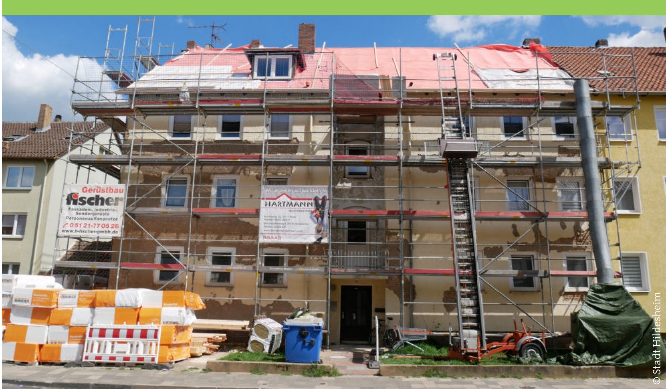
Gestartete Sanierungsarbeiten an der Fassade Bugenhagenstraße 24
