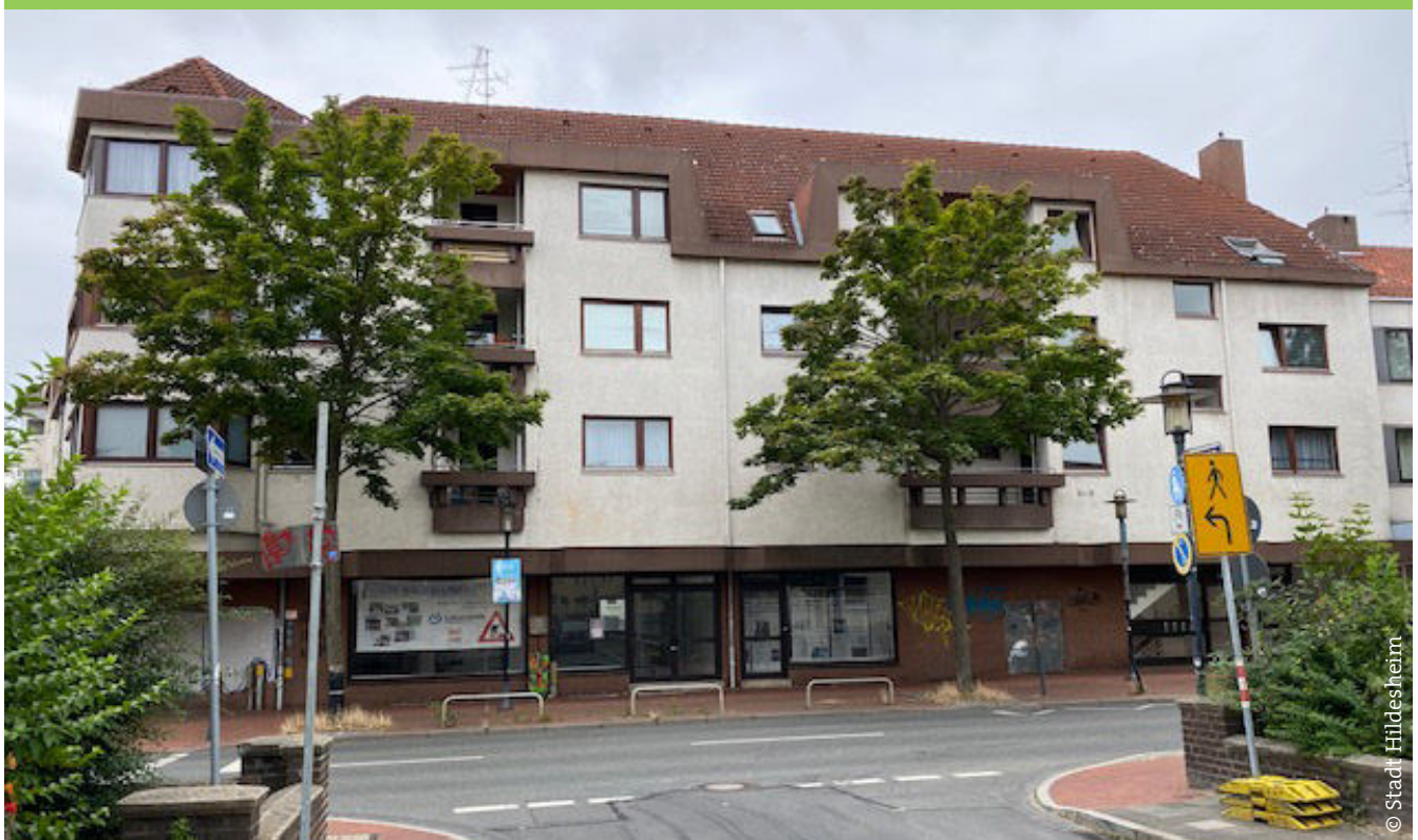
Im Erdgeschoss der Martin-Luther-Straße 41a soll ein Kultur- und Bildungszentrum entstehen
