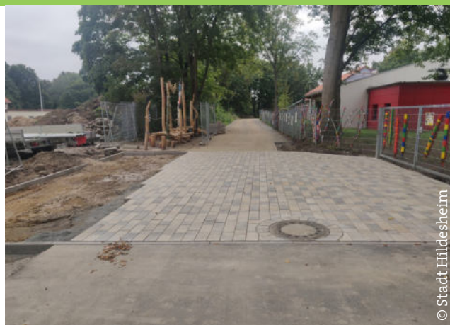
Die Pflasterarbeiten markieren den Schuleingangsbereich
