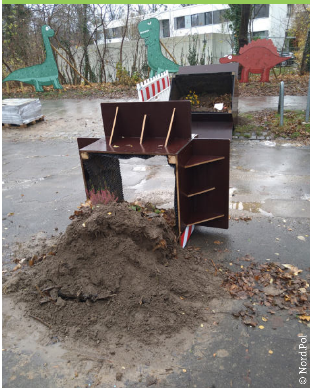
Vandalismus in der Justus-Jonas-Straße
