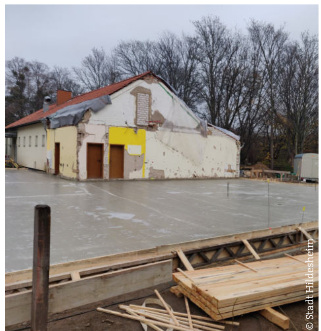
Wenig später: Arbeiten für die Bodenplatte des Neubaus
