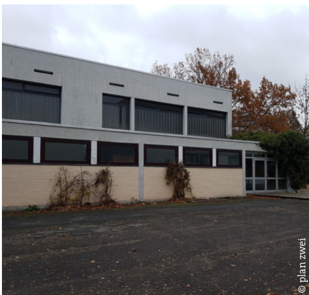
Die ehem. Aula im aktuellen Zustand
