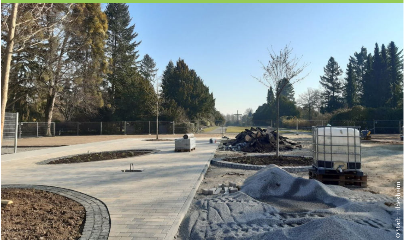
Die Umbauten am Westeingang zum Nordfriedhof nehmen Gestalt an. Die Lieferung des neuen Eingangstors verzögert sich erheblich
