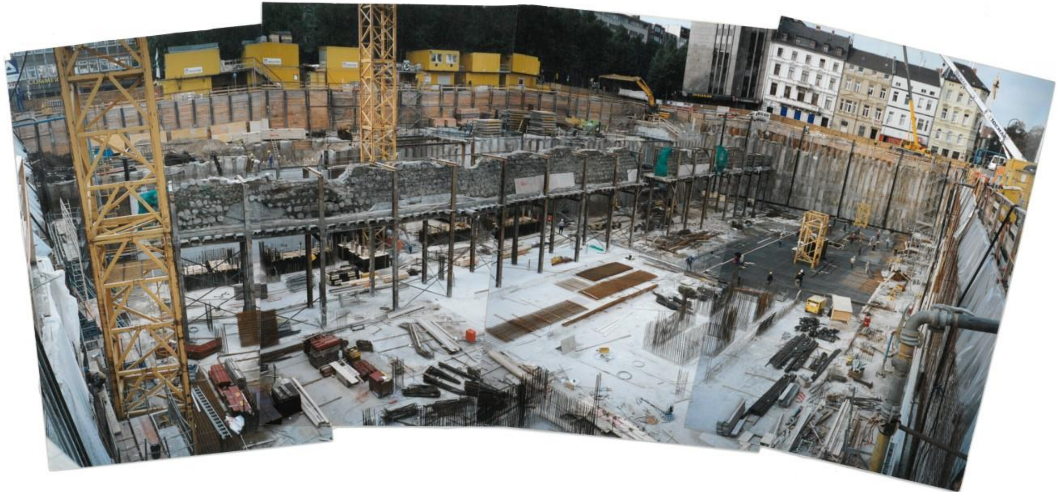
Grabenfangmauer, 14. Jh., Habsburgerring „Westgate“ (2009) Tiefgarage
