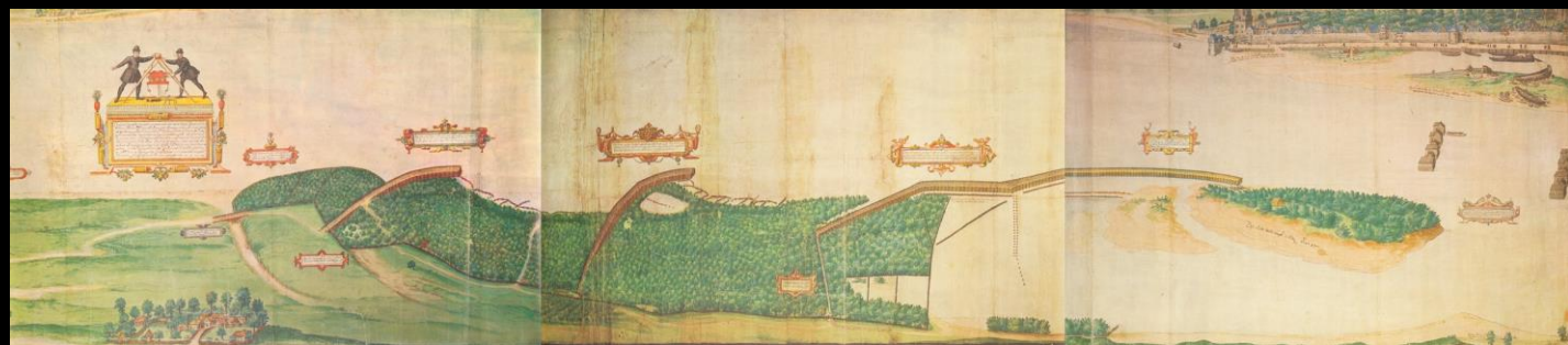
„Poller Köpfe“: Mittelalterliche Uferbefestigungen aus havarierten Frachtschiffen
