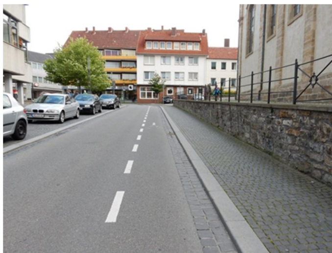
Abb. 7 Schutzstreifen als Schonraum für Radfahrende und als „Reservefläche“ für große Fahrzeuge (Hildesheim, Kreuzstraße)
