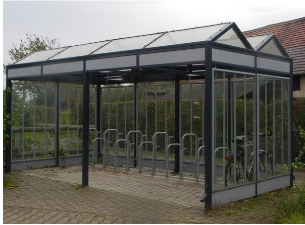
Abb. 75 Beispiel überdachte Bike&Ride-Anlage Bruchsal
