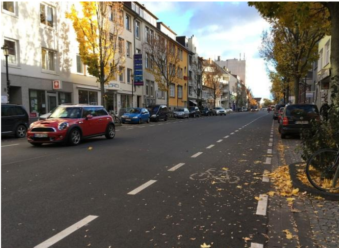
Abb. 8 Schutzstreifen mit Sicherheitstrennstreifen zu parkenden Kfz (Hildesheim, Bahnhofsallee Nord)
