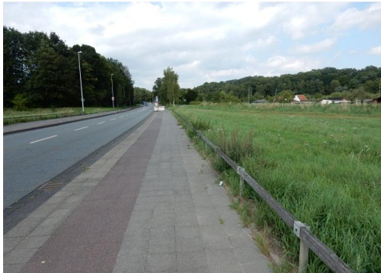
Abb. 4 Nicht benutzungspflichtiger baulicher Radweg (Hinweis: unzureichende Breite) (Hildesheim, Hohnsen)
