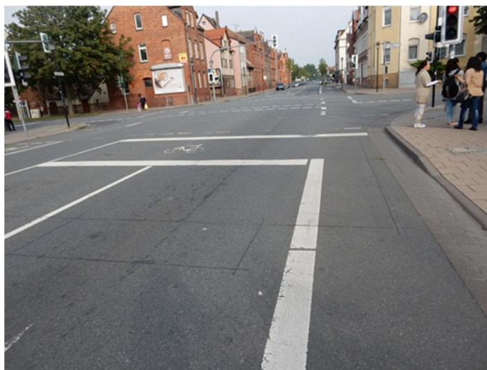
Abb. 14 Aufgeweiteter Radaufstellstreifen (ARAS) mit Möglichkeit zum direkten Linksabbiegen (Hildesheim, Steuerwalder Straße)
