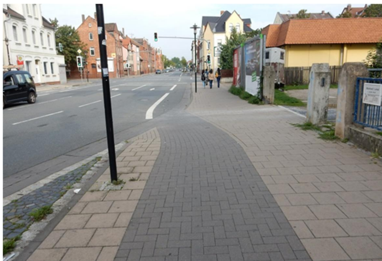
Abb. 12 Übergang Radweg in Radfahrstreifen an signalisiertem Knotenpunkt (Hildesheim, Steuerwalder Straße)
