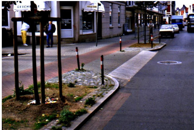
Abb. 11 Teilaufpflasterung im Einmündungsbereich einer Nebenstraße (Beispiel Bremen)
