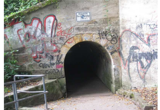
Unbeleuchtete Unterführung im Zuge einer wichtigen Radverkehrsverbindung
