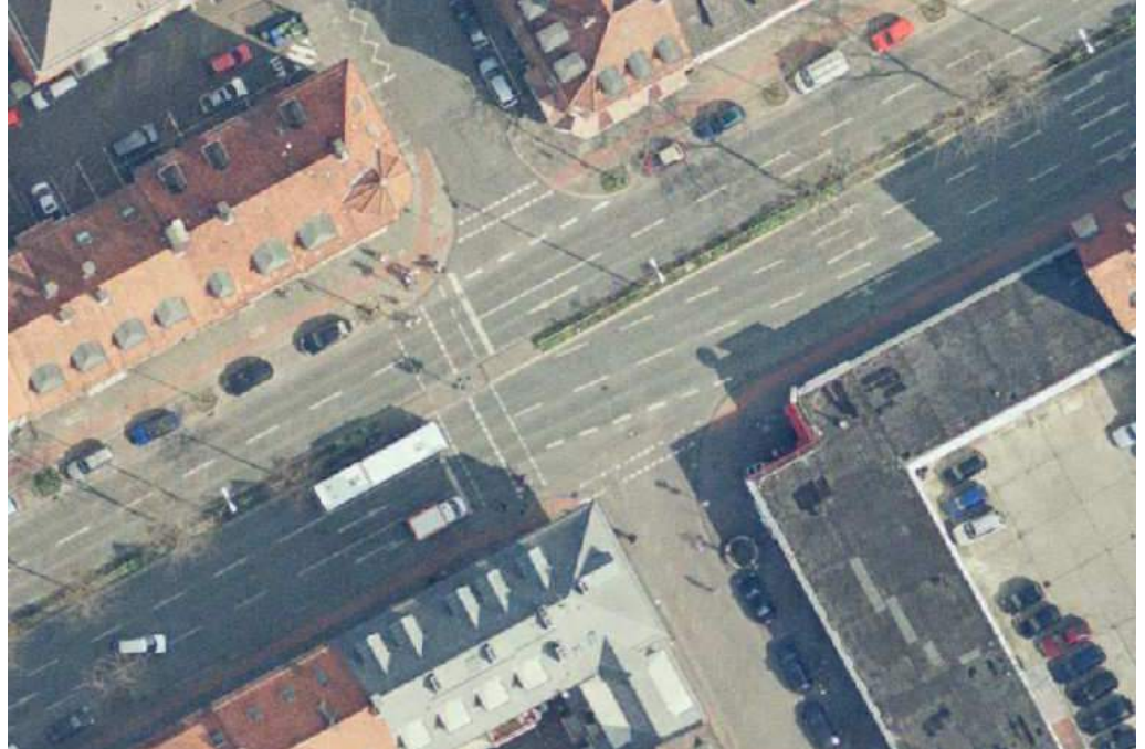
Abb. 54 Überquerungsstelle mit nur einer Fußgänger- und Radfahrer-Furt (Hildesheim, Kaiserstraße)
