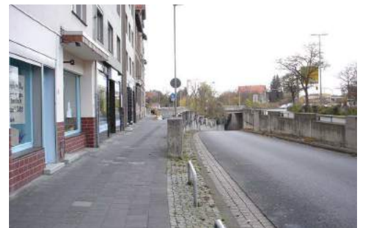
Engstelle in der Zufahrt zum Klingeltunnel (Fahrtrichtung Innenstadt)
