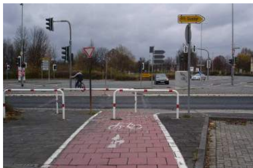
Unnötige Umlaufschranke im Zuge eines Radweges
