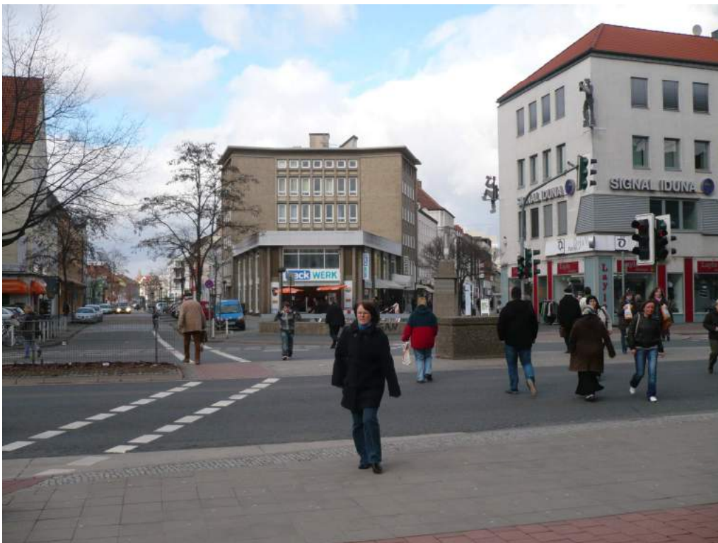
Abb. 64 Fußgängerlichtsignalanlage an der Kreuzung einer Hauptfußgängerachse mit einer Hauptverkehrsstraße
