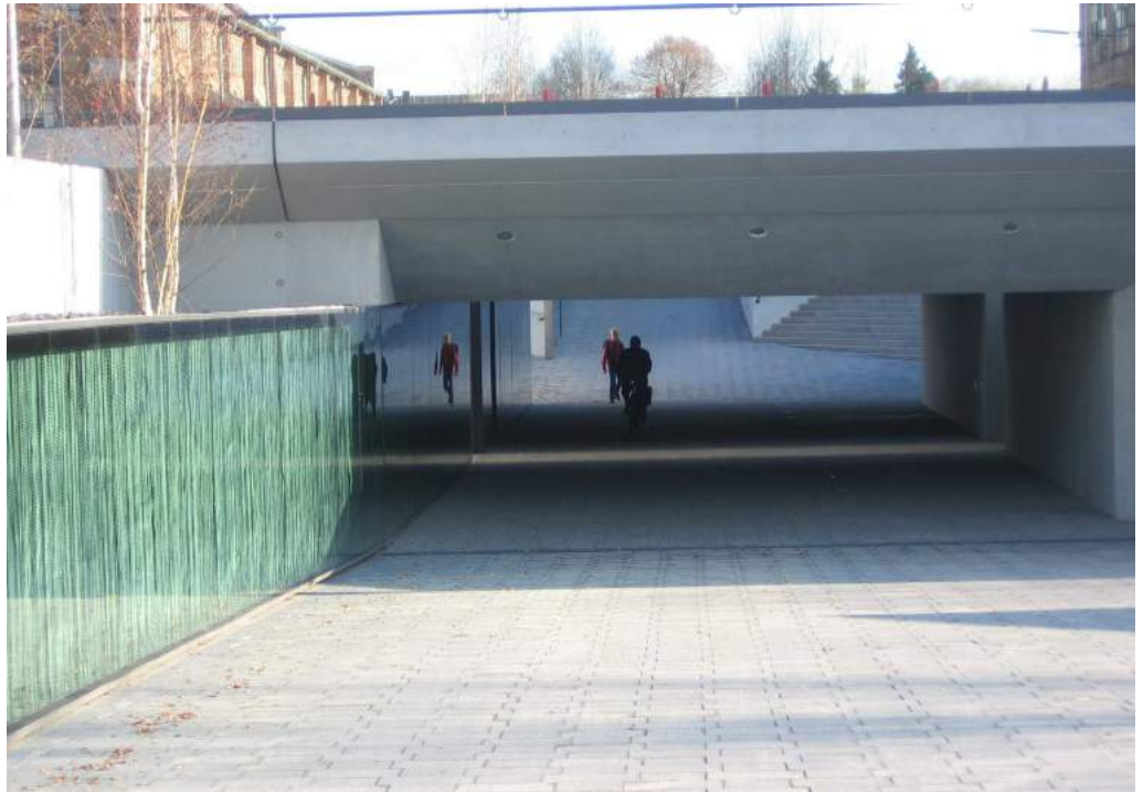
Abb. 67 Breite, ausreichend ausgeleuchtete Unterführung (Lingen/Ems)
