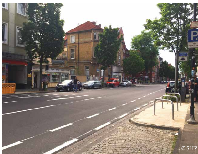
Umbau Parkfläche zu Fahrradabstellanlage
