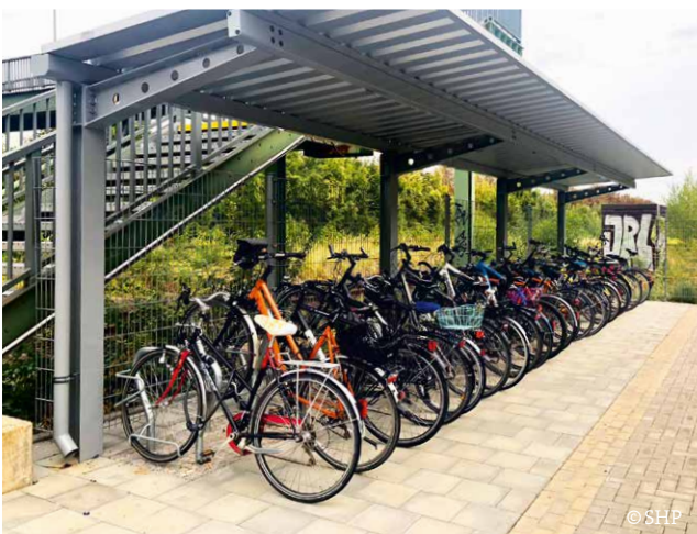
Neue Anlage am Ostbahnhof
