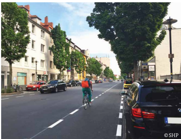
Beispiel: Bahnhofsallee Nord „Schutzstreifen“
