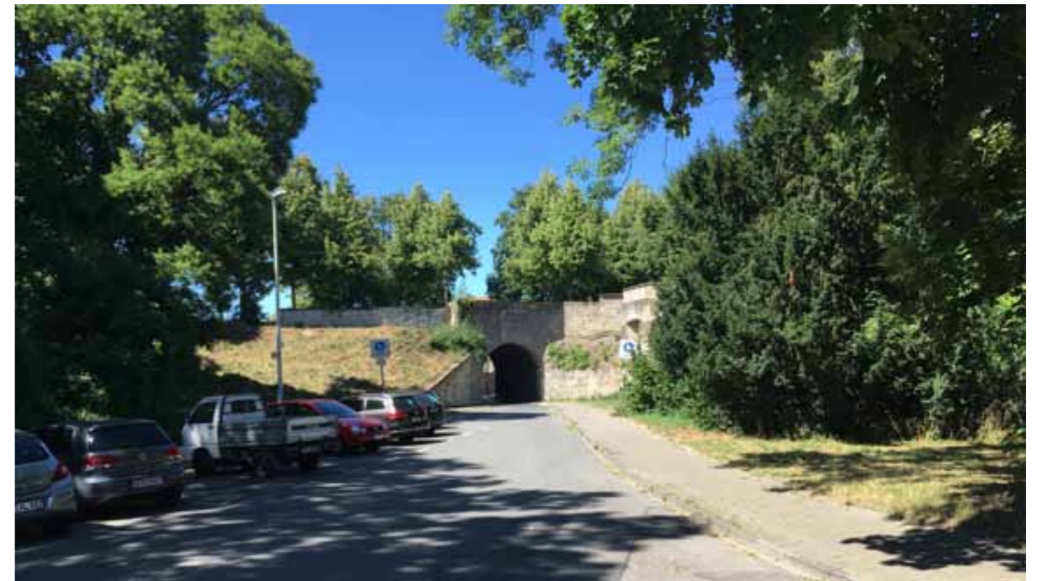
Verbindung Dyesgraben – Kehr wiedergrund mangelhaft auffindbar
