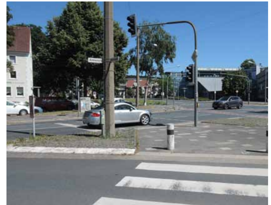
Einmündung Annenstraße überdimensioniert
