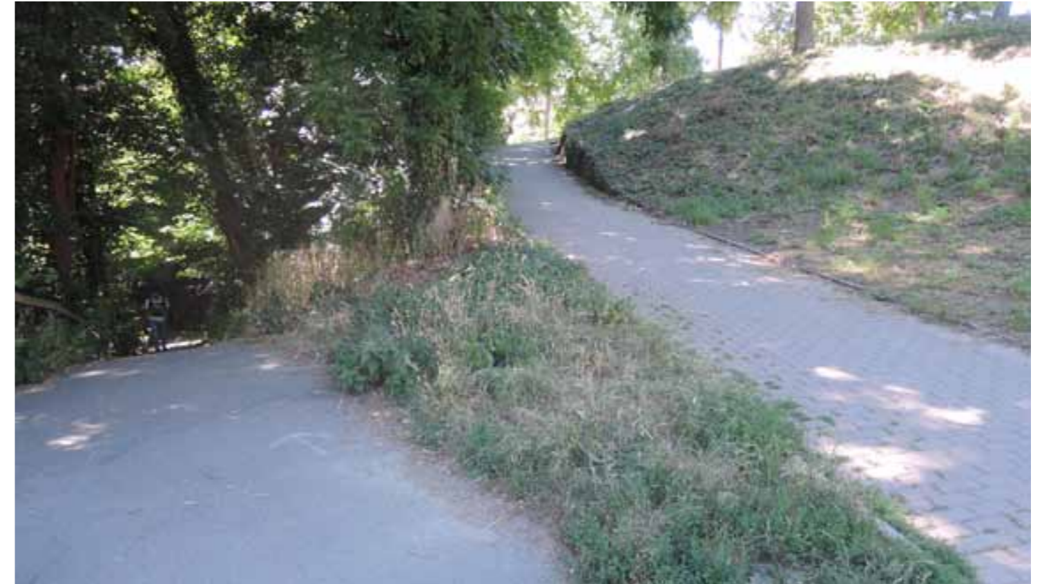
Orientierung am Entrée Dyesgraben mangelhaft
