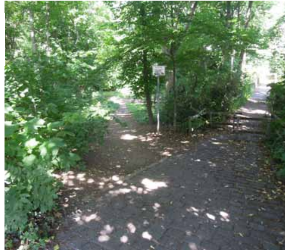
Schlechter Zustand Hangwege
